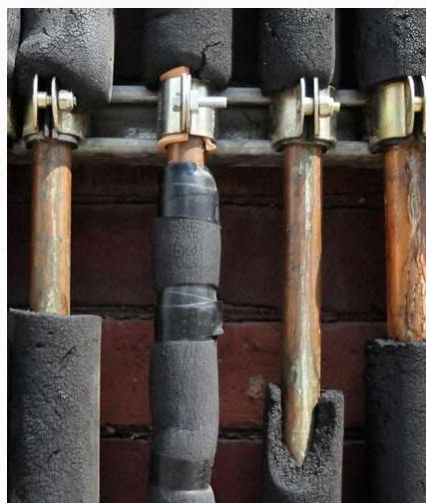
Le calorifugeage des tuyaux extérieurs de réseaux d'eau chaude sanitaire ou de chauffage
